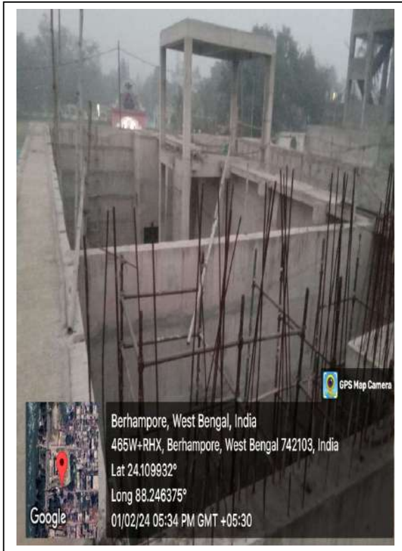
BEHARAMPORE STP SITE
